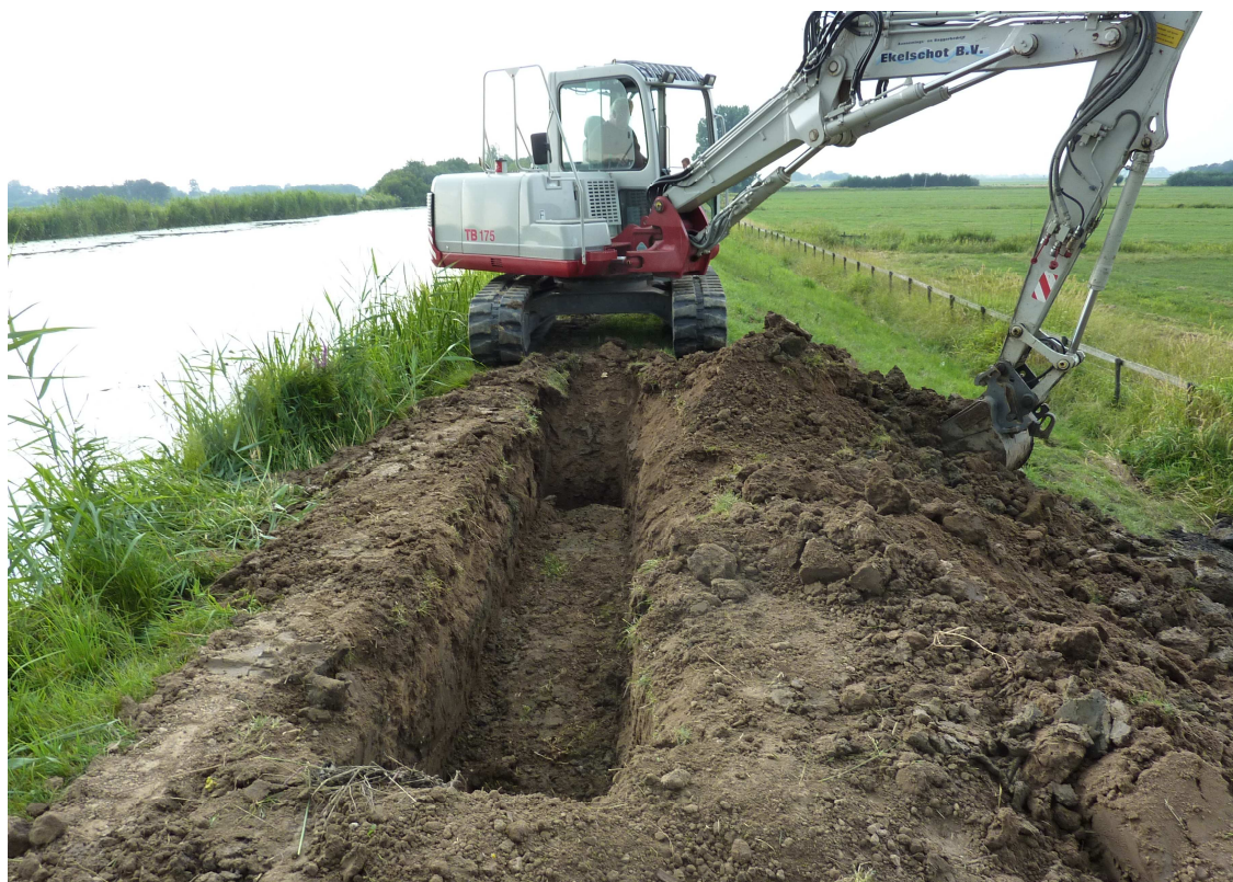
Herstelwerkzaamheden van een afdeling keringen, nadat graafwerk van de muskusrat de kering had aangetast.
