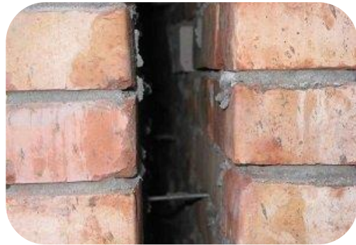
Minimale spouwruimte
