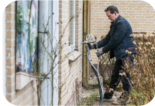
Spouwmuurisolatie
