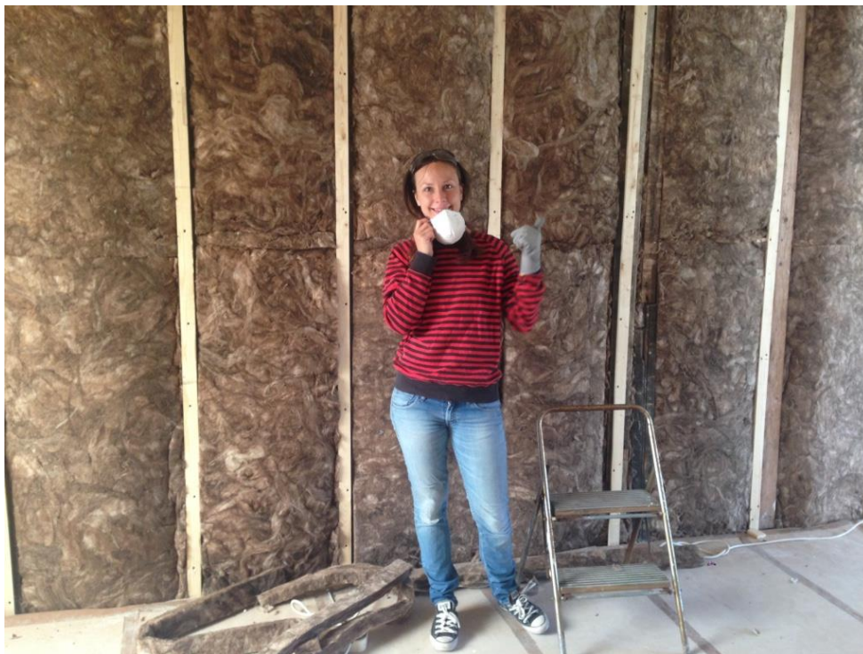
Isoleren binnen gevel
