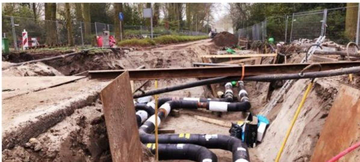
Bouwwerkzaamheden warmteleidingen voor stadswarmte
