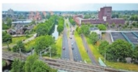
▲ De brug moet kanaal en weg overspannen. FOTO: NARTEN/SPINX
