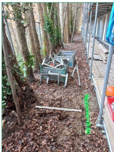
Afbeelding B2.4.1 Profielsleuf 4
