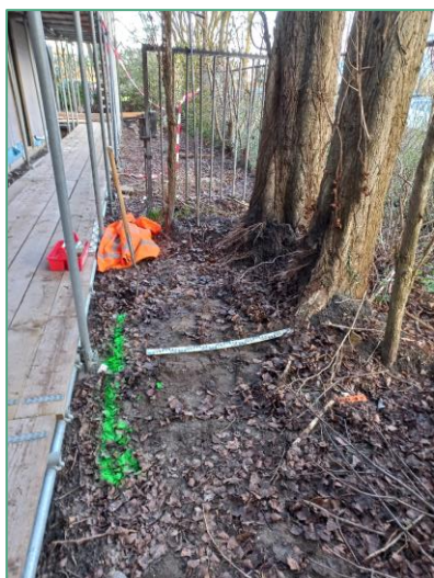
Afbeelding B2.5.1 Profielsleuf 5
