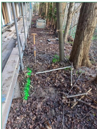
Afbeelding B2.3.1 Profielsleuf 1
