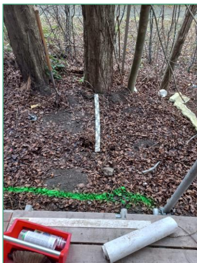
Afbeelding B2.1.1 profielsleuf 1
