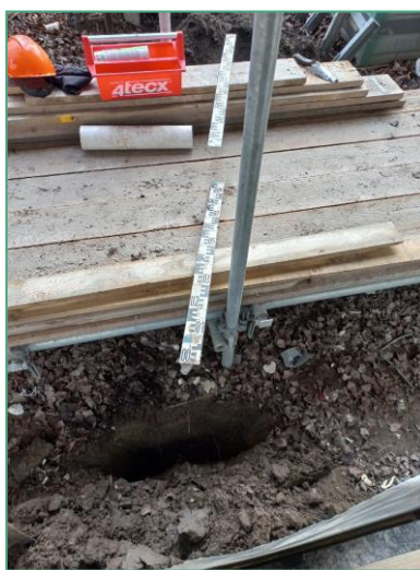
Afbeelding B2.4.4 Aanvullende sleuf bij fundering
