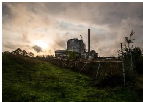
▲ Energie centrale Nijmegen. © DGR/Rulger Van Der Zalm
