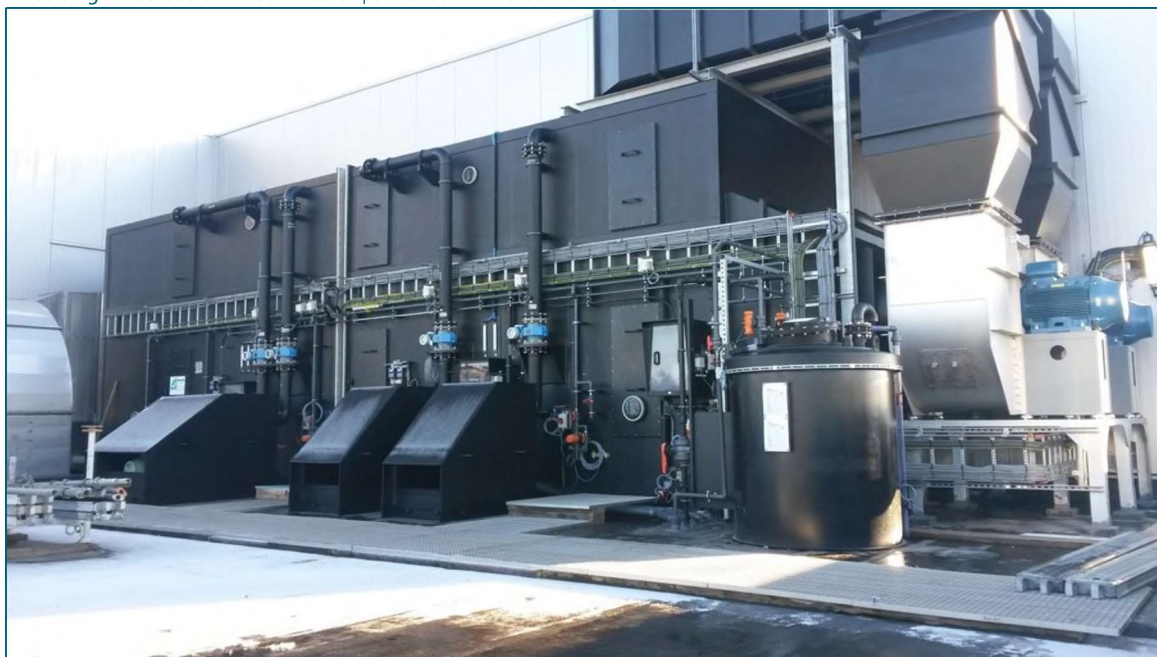
Afbeelding 1 Voorbeeld van een meertraps kruisstroomwasser Askové
